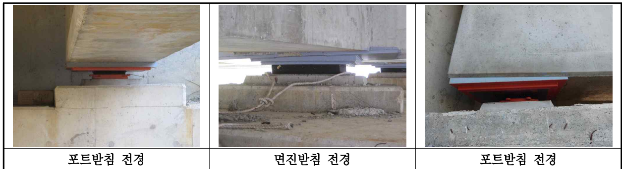
【사진 13.3.12】 교량반침 전경
