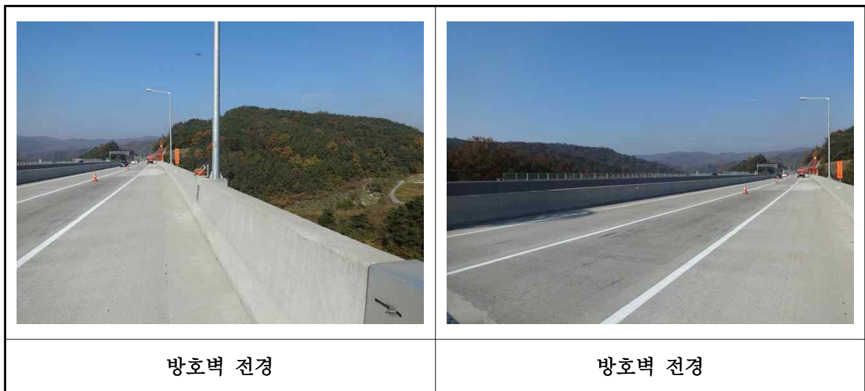
【사진 13.3.23】 방호벽 및 중앙분리대 전경
