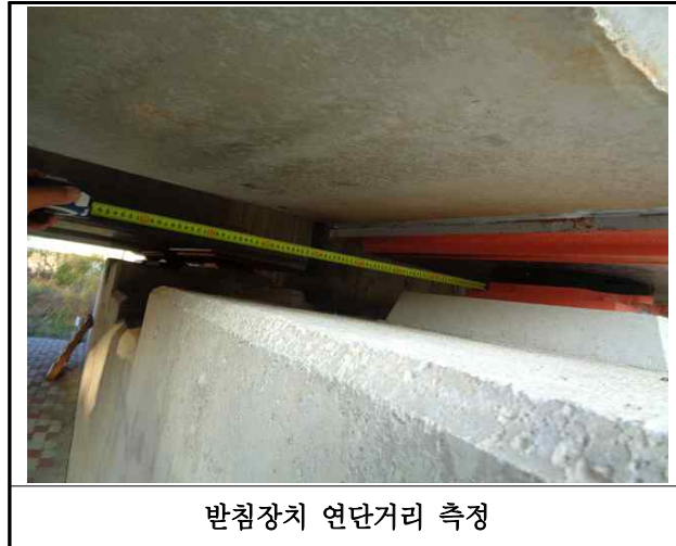
【사진 13.3.37】 교량받침장치 연단거리측정
