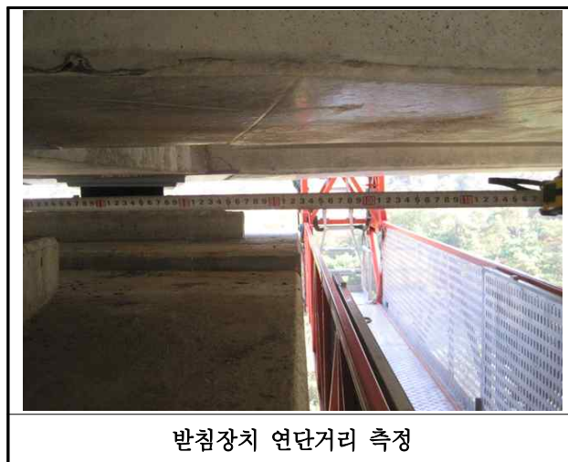
【사진 13.3.14】 교량받침장치 연단거리측정
