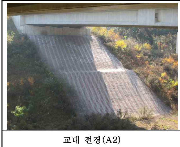
【사진 13.3.31】 교대 전경
