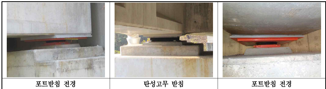
【사진 13.3.35】 교량반침 전경
