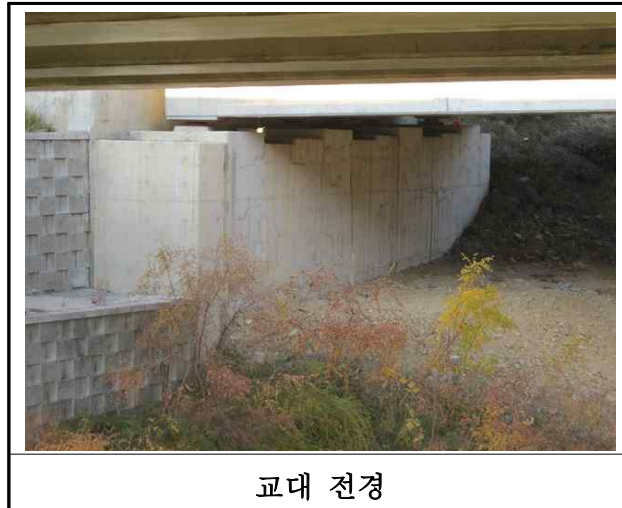
【사진 13.3.8】 교대 전경
