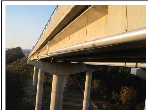
거더 내측 전경
