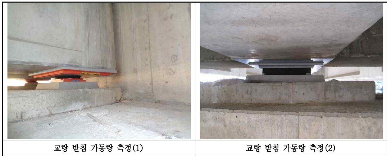
【사진 13.3.38】 교량받침 이동량 측정
