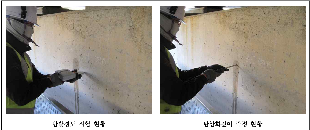
【사진 13.4.1】 콘크리트 내구성조사 현황
