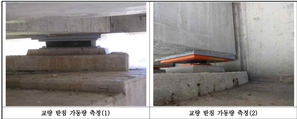
【사진 13.3.15】 교량받침 이동량 측정
