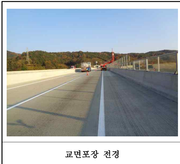
【사진 13.3.42】 교면포장 전경
