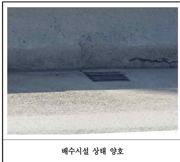
【사진 13.3.22】 배수시설 손상현황
